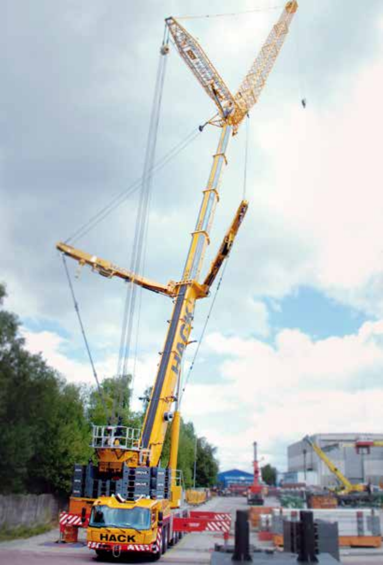
Erster Einsatz für den neuen GMK6400 der Hack GmbH – und sofort mit Wippe.
